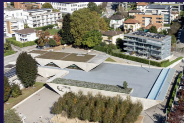
PIAZZALE CENTRO SCOLASTICO NOIEDO A MASSAGNO
